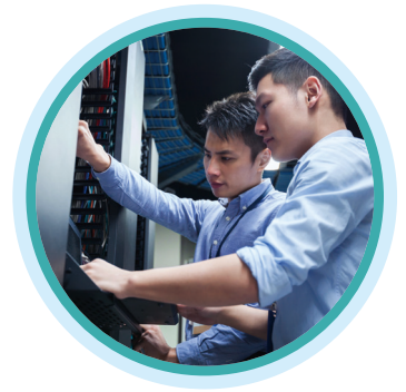
人工巡检操作 高频重复低效
